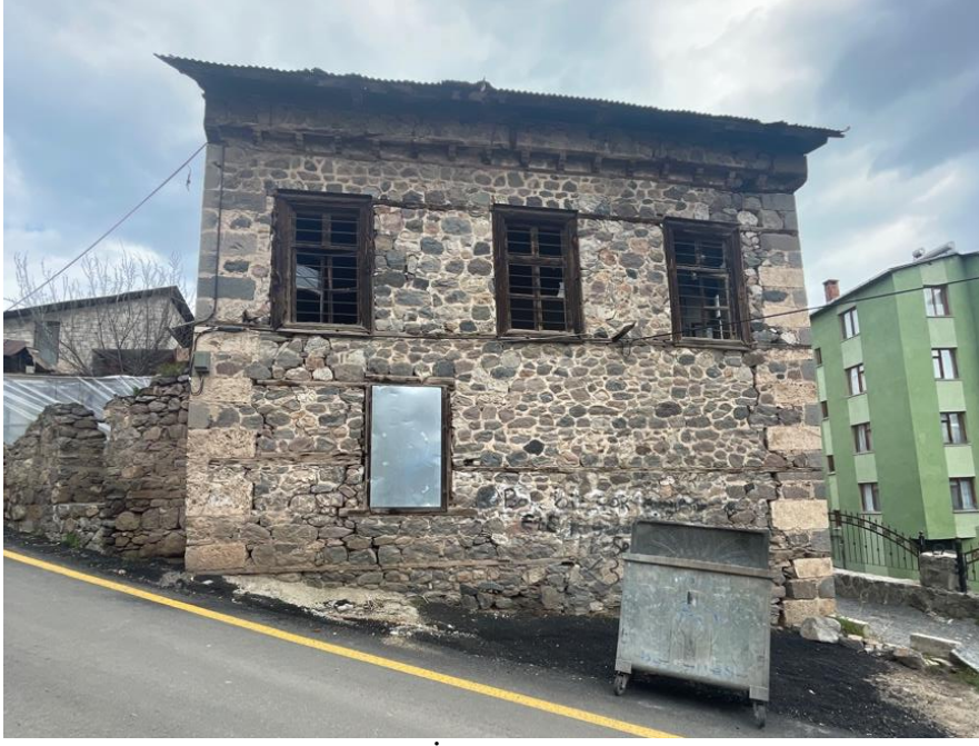
Şekil 11. Geleneksel İspir konutlarında taş dokusu
