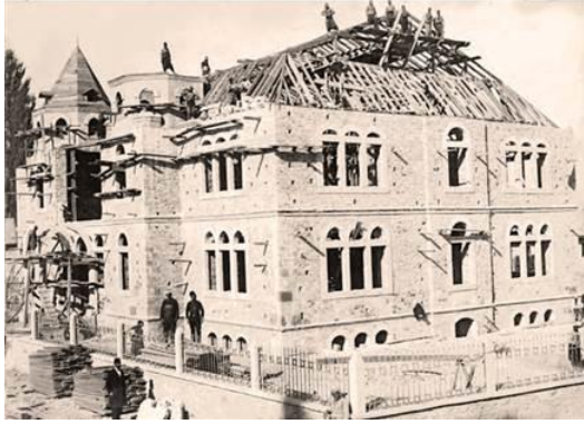
Konya Sanayi Mektebinin İnşaatı (1898-1901)
