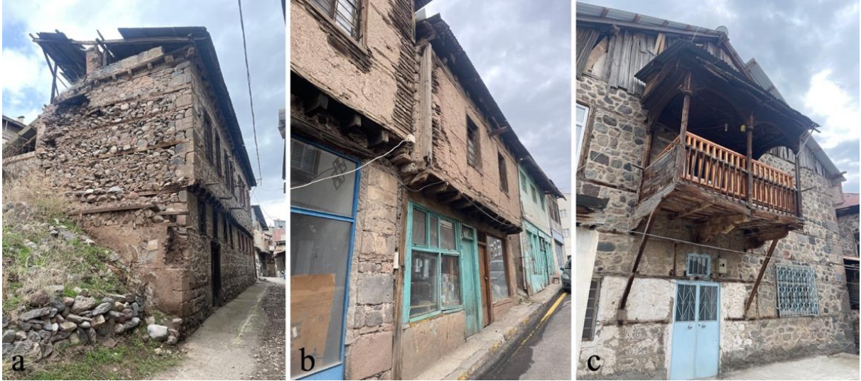
Şekil 14. 1. Tip kapalı çıkma (a), 2. Tip kapalı çıkma (b), Açık konsol çıkma (c)
