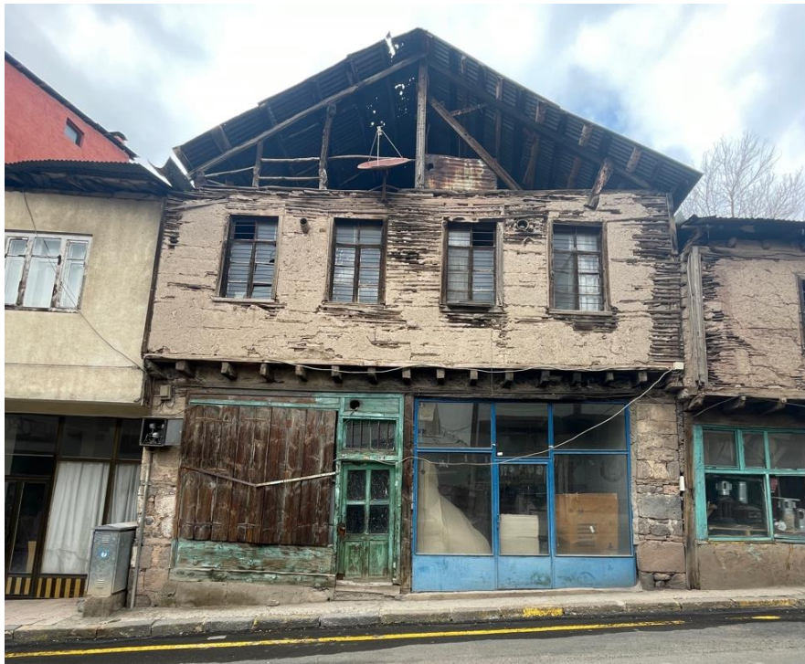
Şekil 12. Üst katta ahşap karkas-bağdadi kaplama ile kerpiç-taş dolgu kullanılan bir konut altı ticaret
