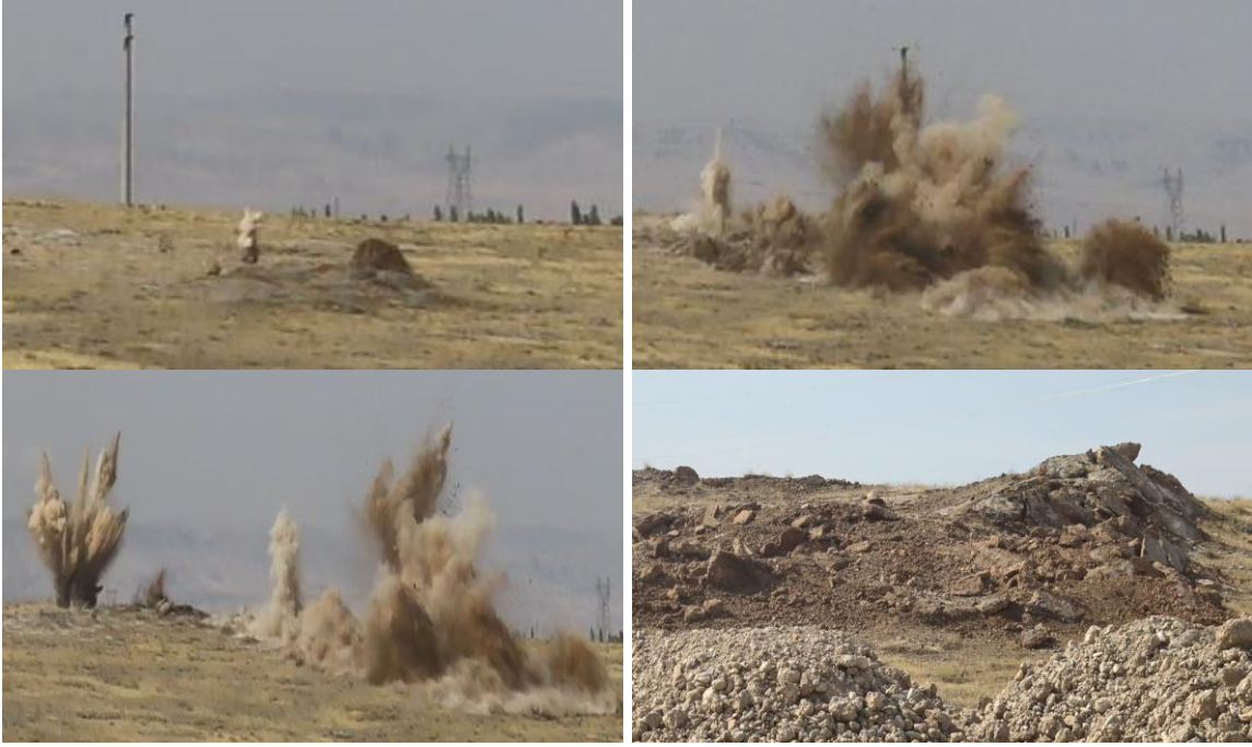
Şekil 10. Patlayıcının sıralı ve gecikmeli infilakı ve patlatmadan sonra görünüm
