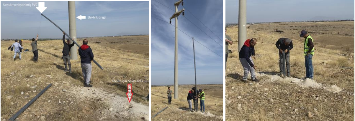
Şekil 8. İvme ölçerin açılan deliklere yerleştirilme işlemi
