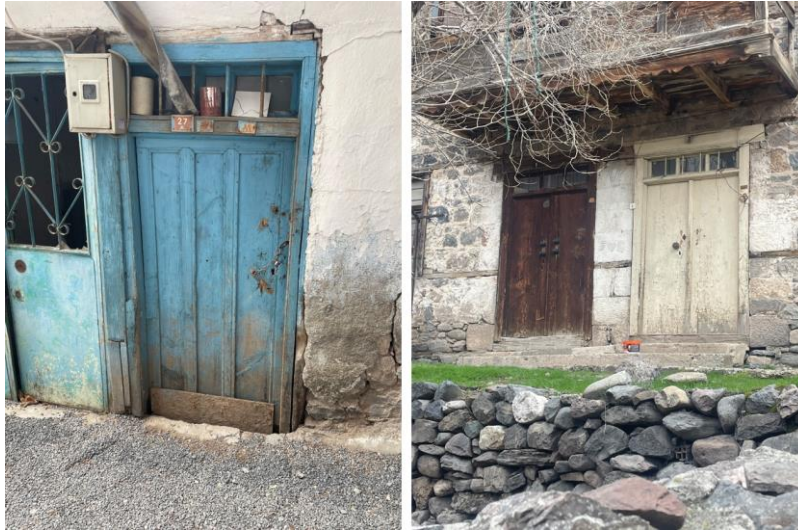
Şekil 15. Solda tek kanatlı kapı, sağda çift kanatlı kapı
