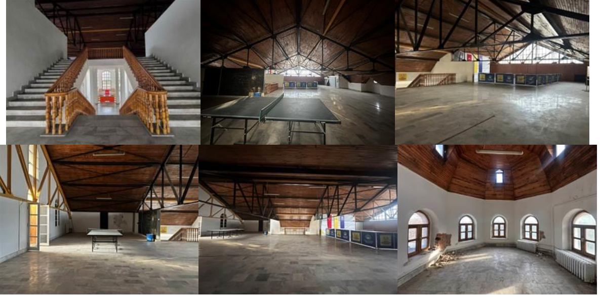
Çatı Kat İç Mekan Fotoğrafları
