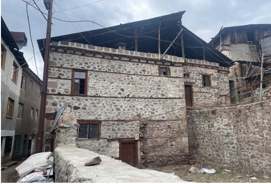
Şekil 13. Düz damlı ve üstüne kırma çatı eklenmiş geleneksel konut
